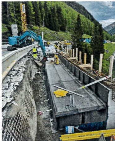
Verbreiterung Straßenbrücke S B23
