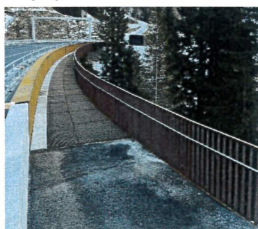
Fußgängerbrücke S B23
